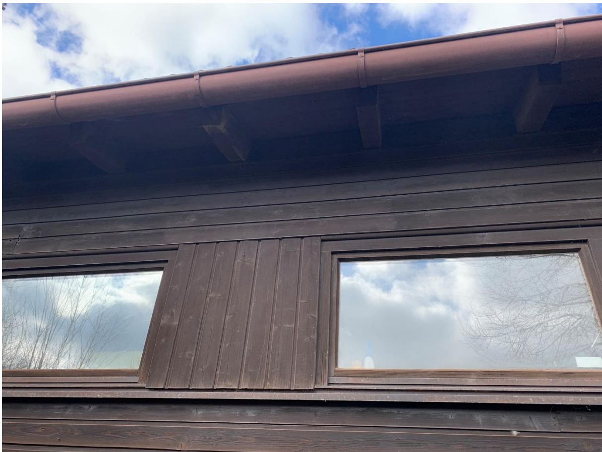
Abb. 7: Fassade des Tennisheims im UG
