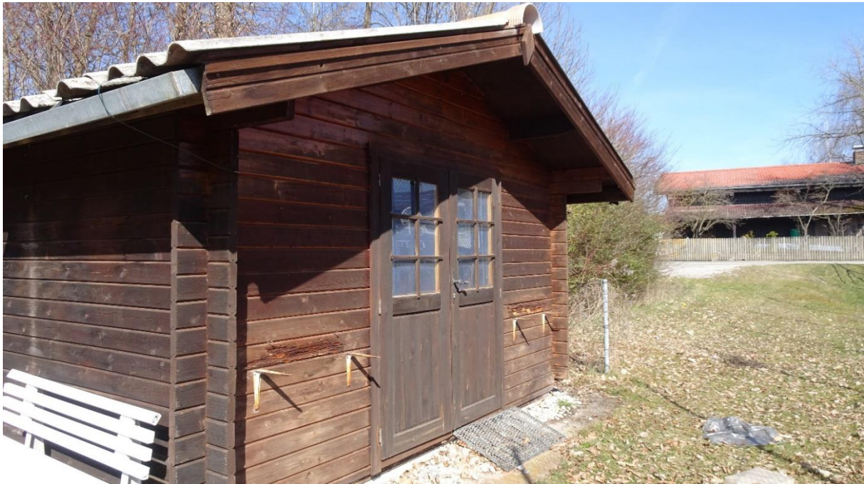
Abb. 8: Holzhütte im UG
