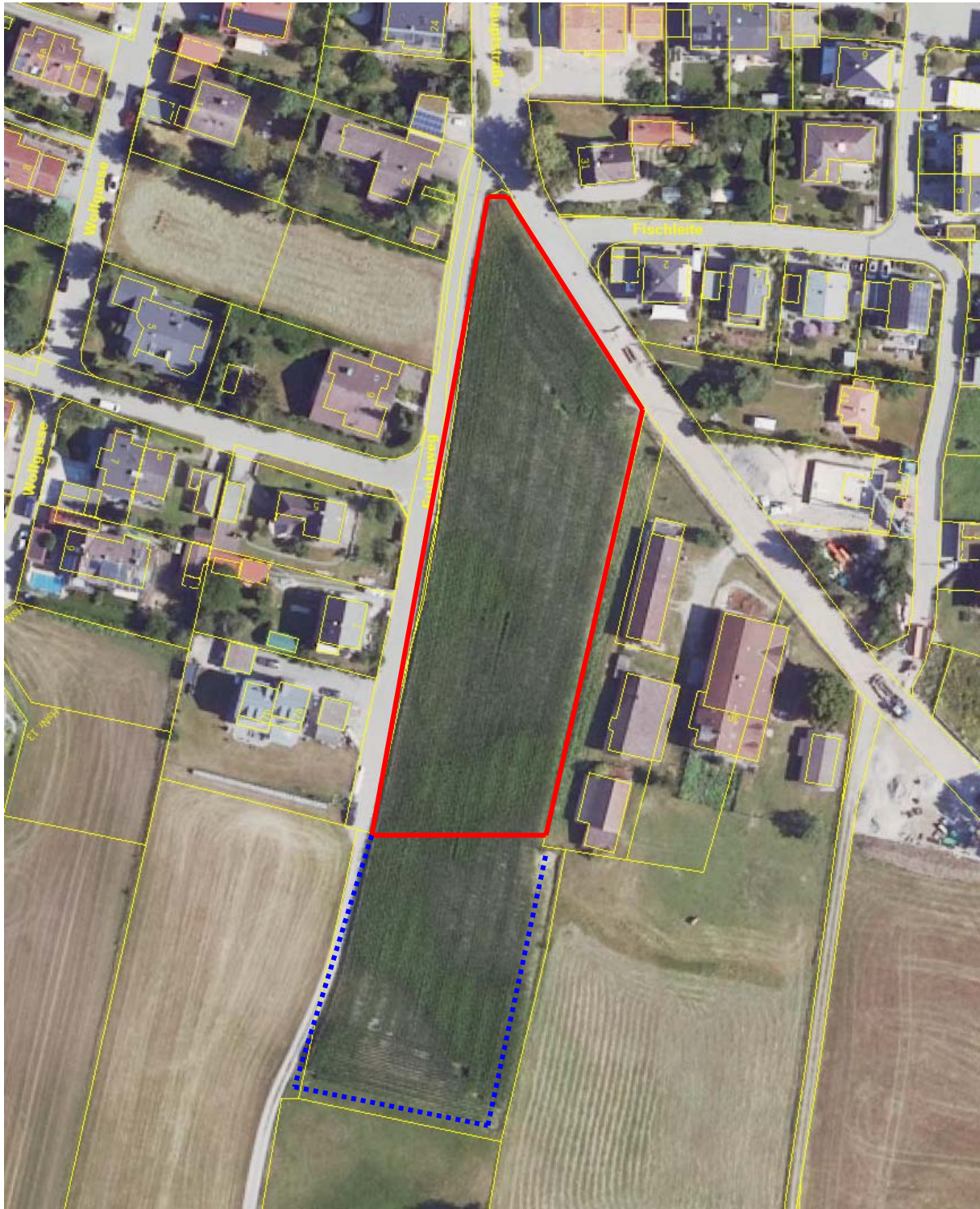
Abb. 1: Geltungsbereich des Bebauungsplans (rot markiert); die blau markierten linearen Strukturen liegen außerhalb des Umgriffs des Bebauungsplans und markieren naturschutzfachlich interessante Raine. (Kartengrundlage: Bayerische Landesvermessung 2022).
