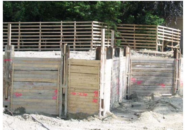
Abbildung 3: Berliner Verbau und Baumschutzzaun
