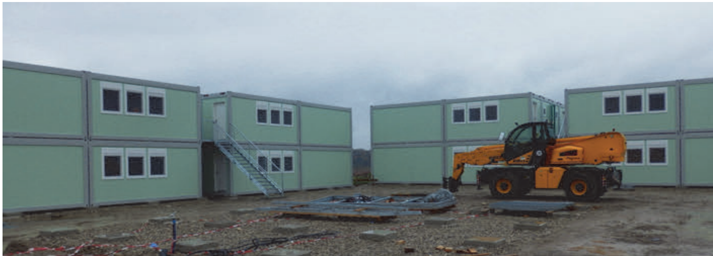
Containeranlage in Herrsching (derzeit im Bau)
